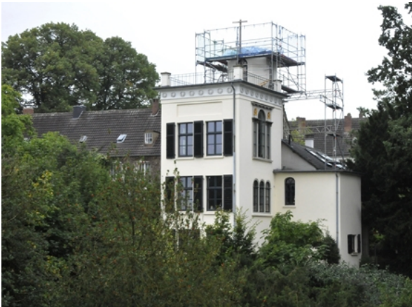
Der Atelierturm mit dem Gerüst zur Montage der Pallas Athene, September 2012
